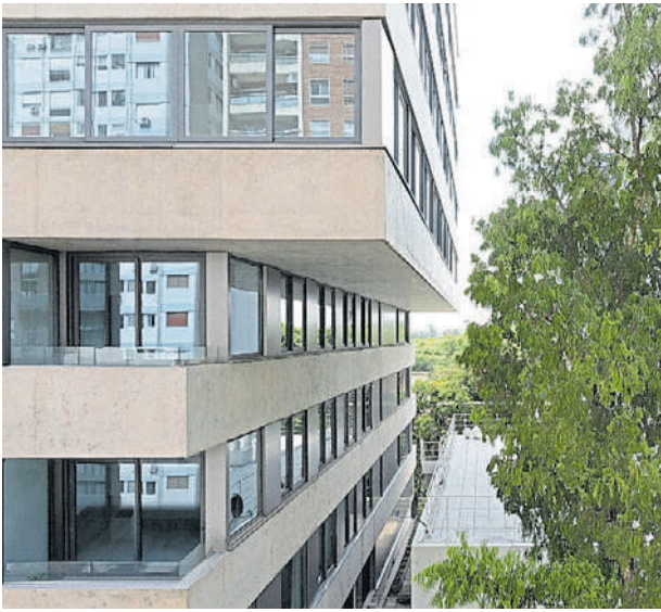
VISUALES. Las carpinterías son de piso a techo.
